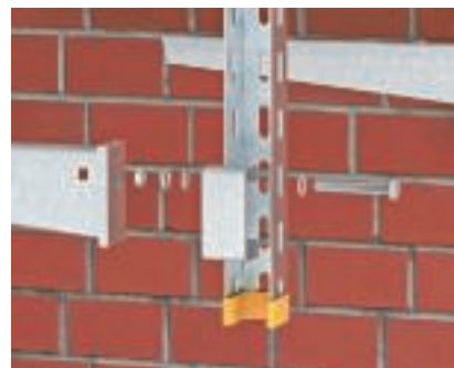
Монтаж кронштейна на U-образной подвесной стойке
