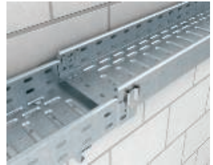
Монтаж секций кабельного лотка
