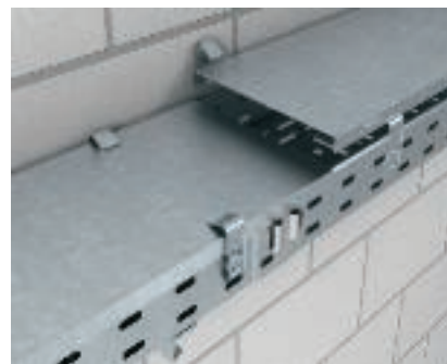
Монтаж крышки с помощью универсального фиксатора
